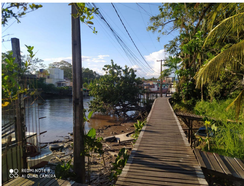
Figura 4 – Passarelas da comunidade do Igarapé da Fortaleza
