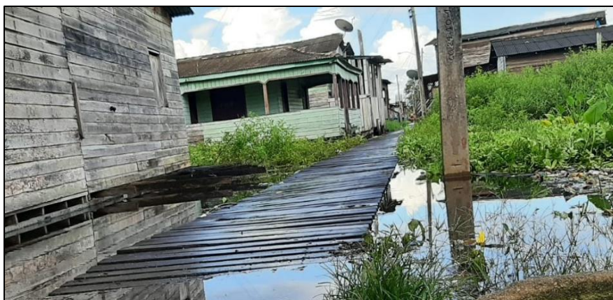
Figura 2 - Áreas de palafitas que interligam a Rua da Antiga Usina.
