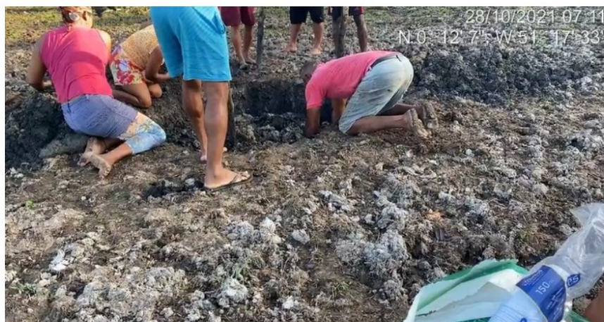
Fotografia 7 - Escavação atingindo 30 centímetros.
