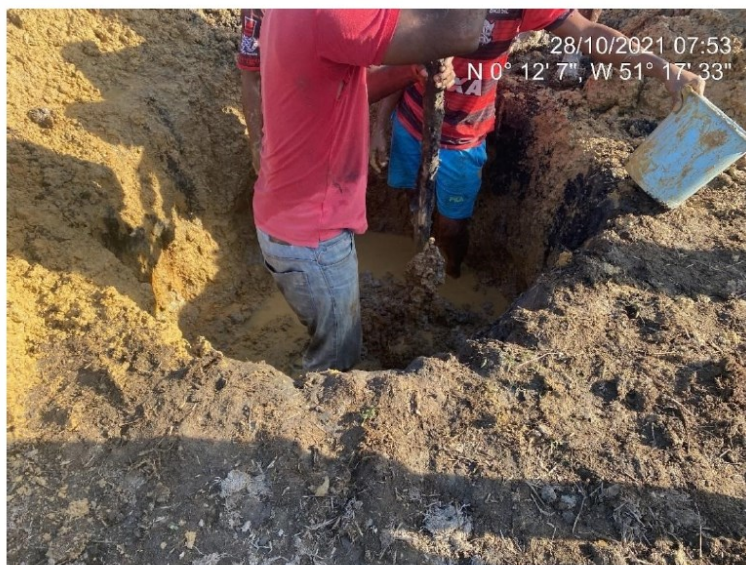
Fotografia 10 - Retirada de água percolada – escavação atingindo 70 centímetros.
