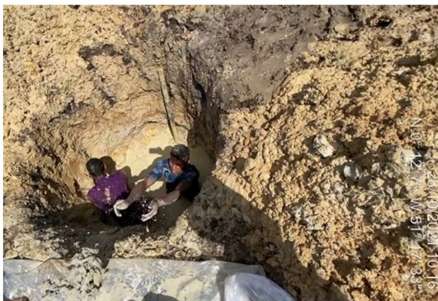
Fotografia 13 - Escavação atingindo 1 metro e 90 centímetros.
