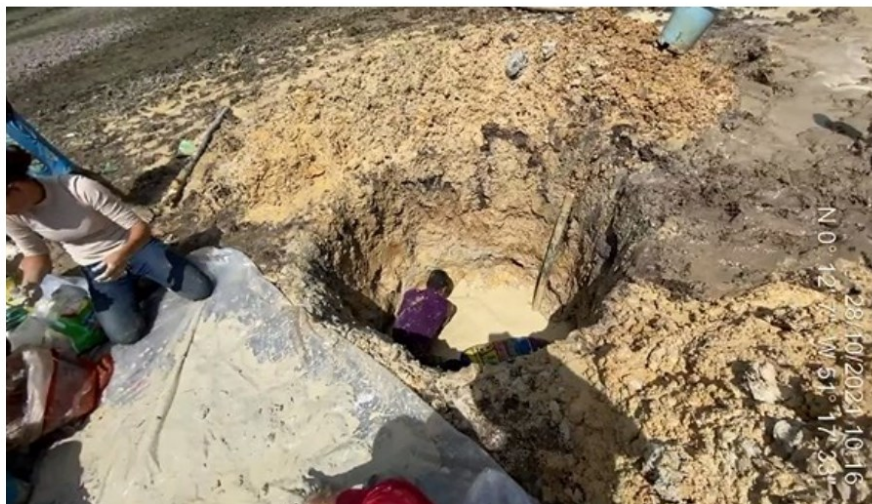
Fotografia 12 - Escavação atingindo 1 metro e 40 centímetros.
