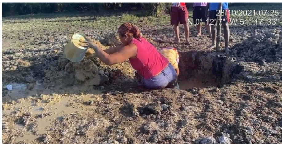
Fotografia 8 - Escavação atingindo 60 centímetros.
