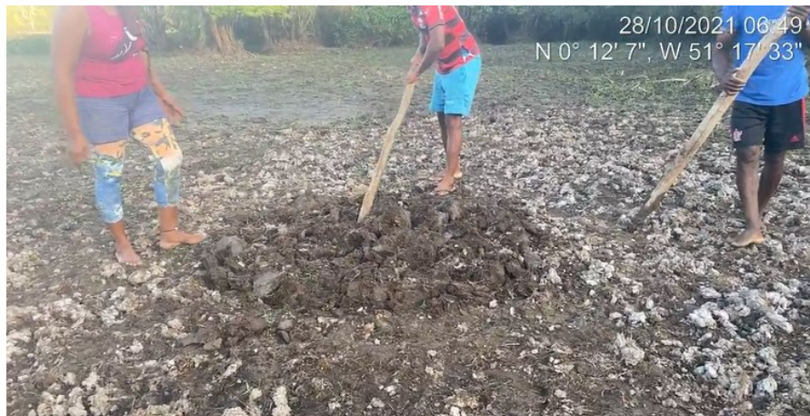
FOTOGRAFIA 1 - Início da escavação – nível zero.
