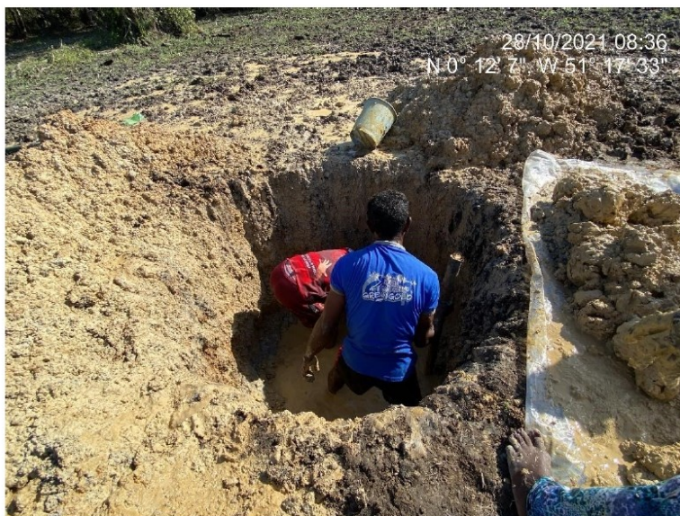
Fotografia 11 - Argila ideal – escavação atingindo 1 metro e 10 centímetros.
