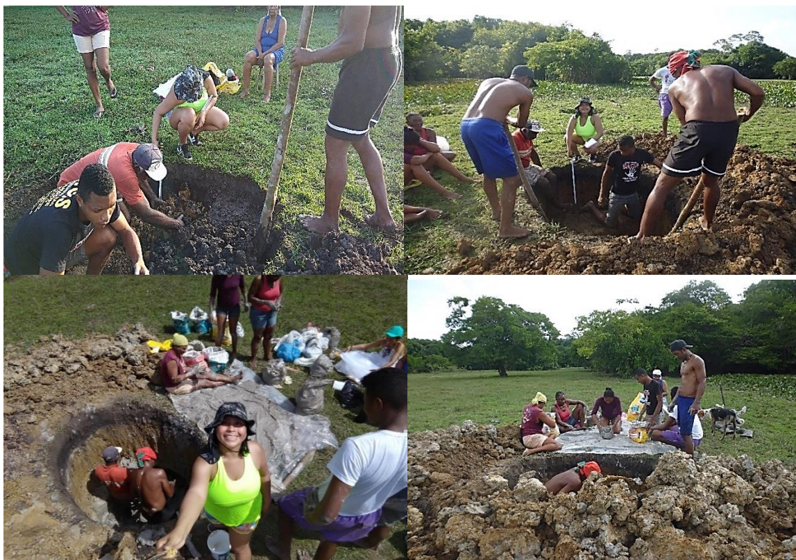
Foto 22- Escavação do buraco.
