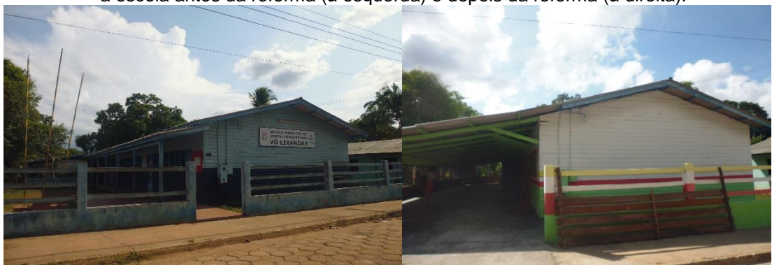
Foto 5- Escola Municipal de Ensino Fundamental Vô Lixandre a escola antes da reforma (à esquerda) e depois da reforma (à direita).
