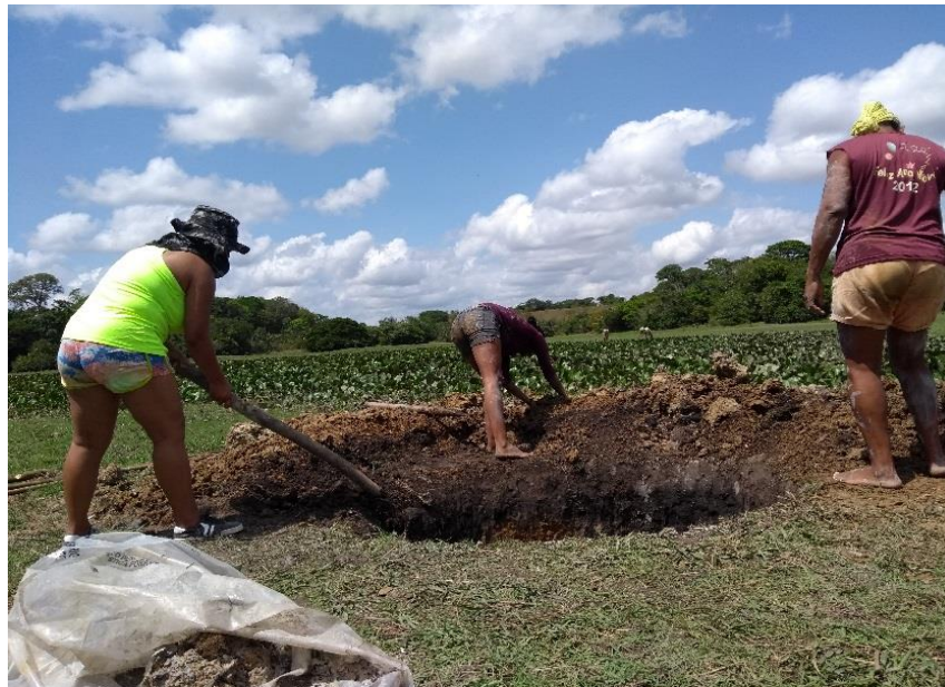
Foto 12- Ajudando a tampar o buraco com terra e argila.
