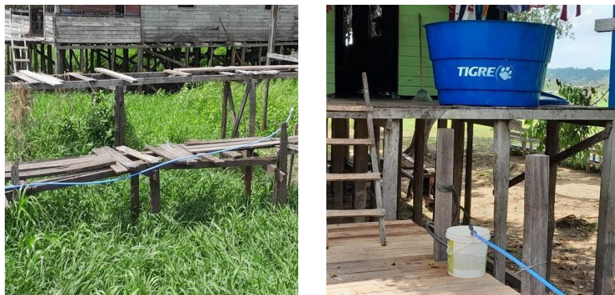
Imagem 5 - Abastecimento de água pela rede pública
