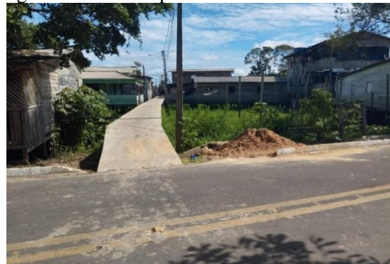
Figura 6 – Foto de passarela de concreto
