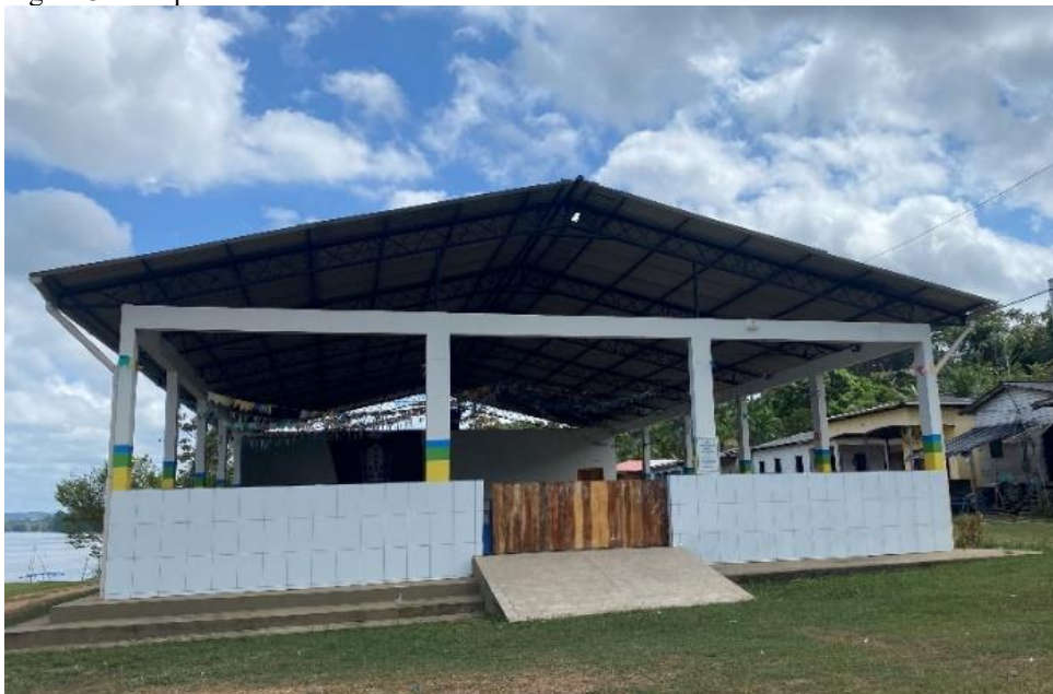
Figura 3 – Galpão de eventos da comunidade.
