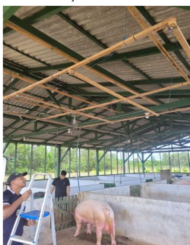
Imagem 4 - Instalação do sistema de coleta.
