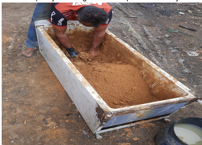
Figura 10 - Preparação da argila utilizada para a construção do forno
