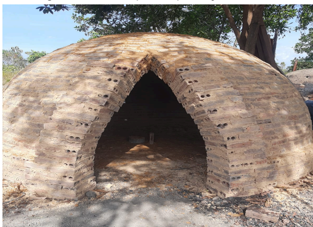
Figura 2 - Forno para a produção de carvão
