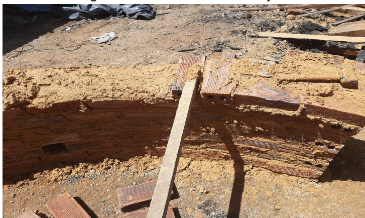
Figura 11 - Assentamento dos tijolos
