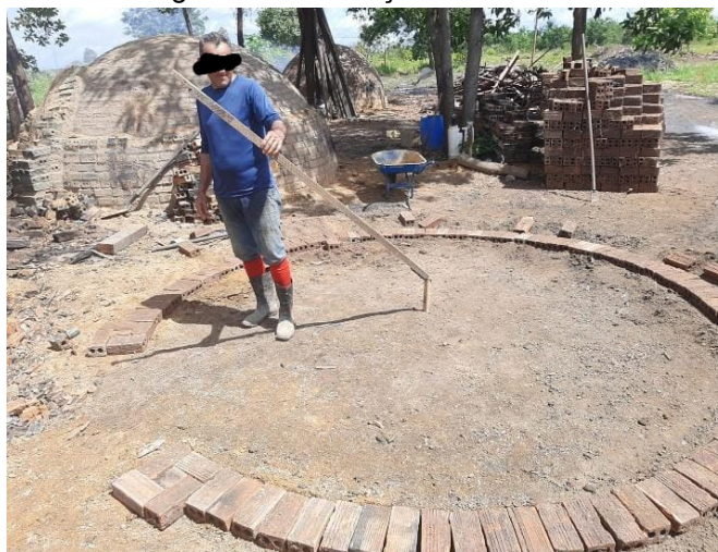
Figura 9 - Construção da base do forno
