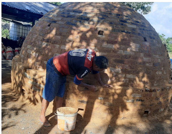
Figura 20 - Última etapa da construção do forno
