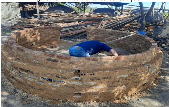
Figura 15 - Andamento da construção
