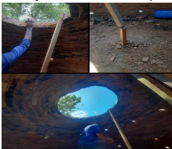
Figura 18 - Andamento da construção
