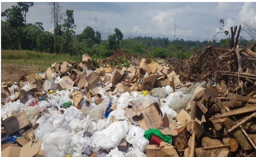
Figura 11 - Área destinada aos Resíduos de Construção Civil.
