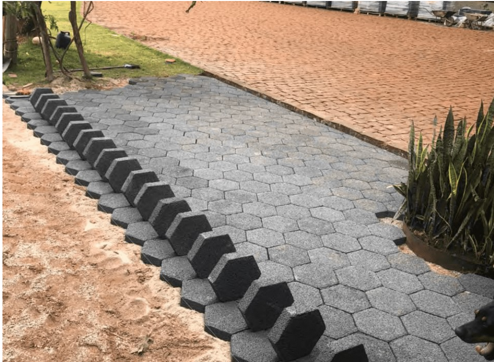
Figura 14 - Calçada de paver sextavado.
