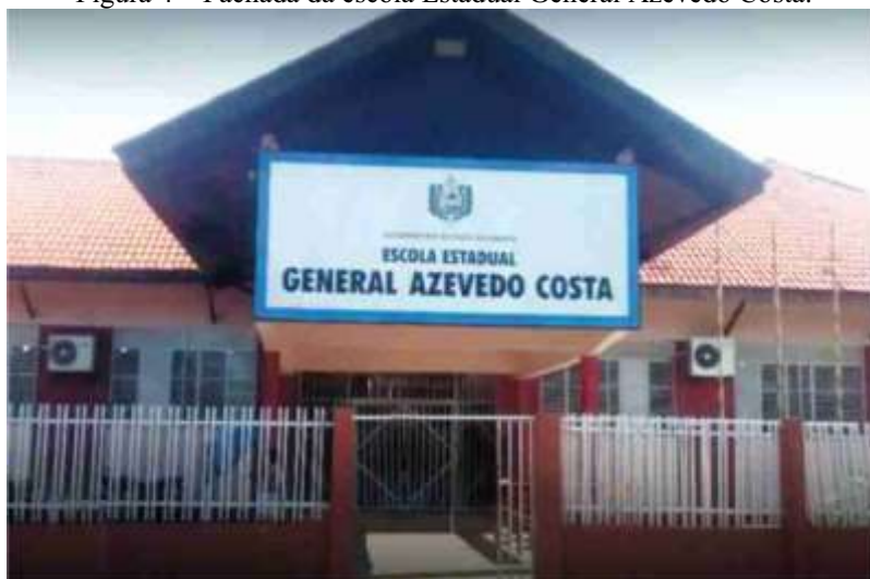
Figura 4 – Fachada da escola Estadual General Azevedo Costa.
