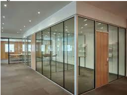
Figura 16 - Portas e Divisórias de Vidro Temperado
