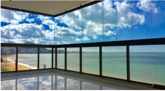
Figura 13 - Fechamento de Varanda
