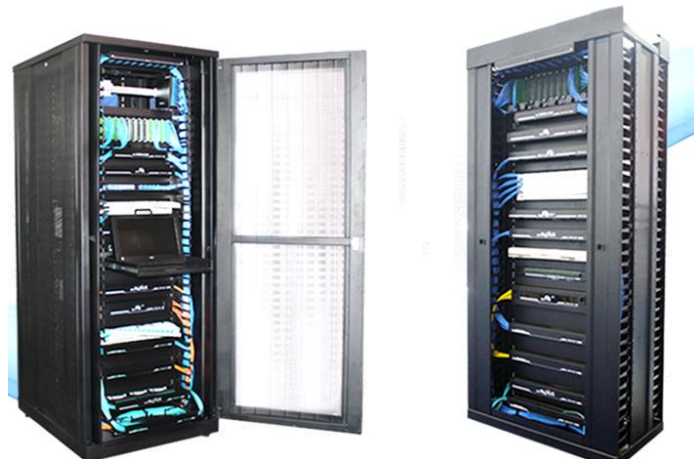
Figura 2 – Ilustração de racks de diferentes tamanho.
