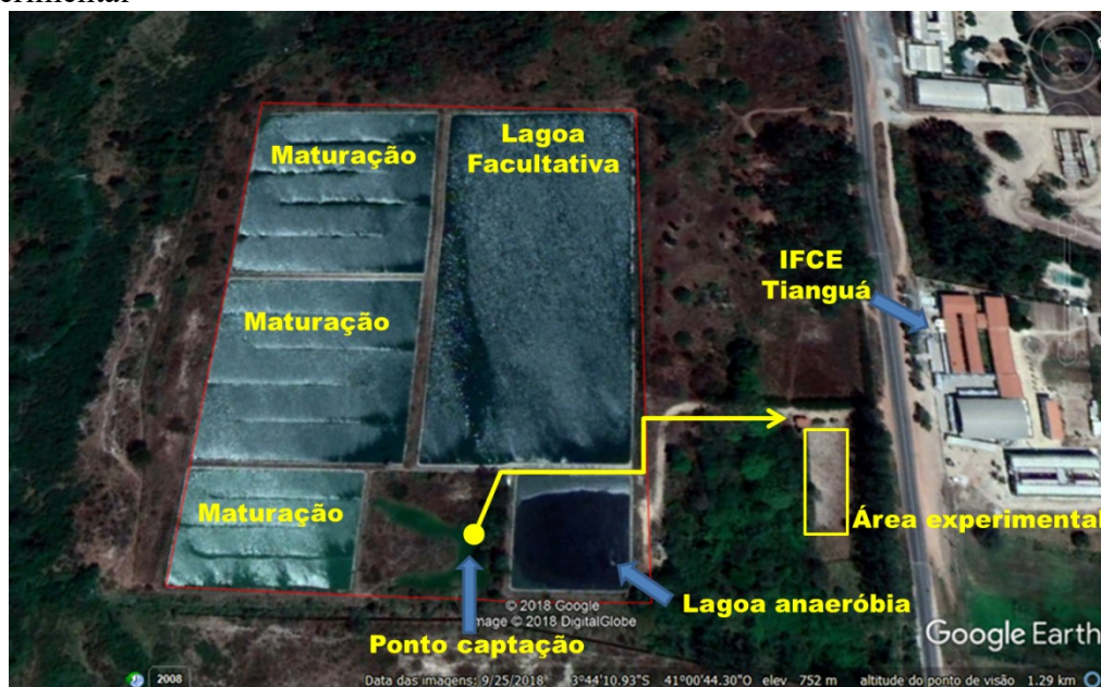
Figura 13 - Estação de Tratamento de Esgoto de Tianguá (ETE São Gonçalo) e a área experimental
