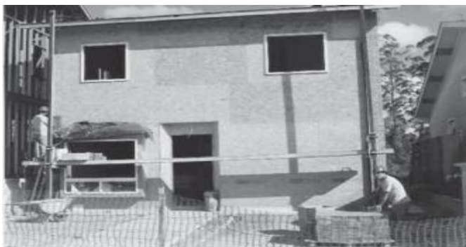
Figura 6 – Fechamento de fachada com placas de OSB.
