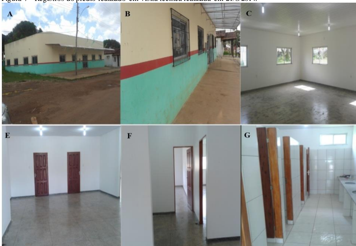
Figura 7 - Registros do prédio realizado em visita técnica realizada em 21/8/2014.
