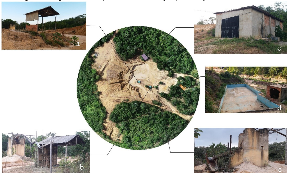
Figura 6 - Imagens da localização das estruturas de operação do empreendimento minerário.
