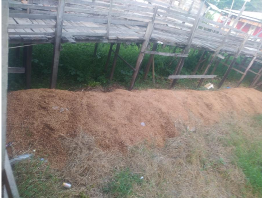
Figura 15: Aterro de área alagada com resíduo do açaí
