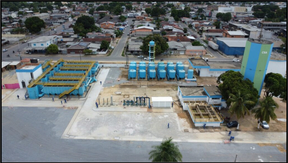
Figura 13 – Visão aérea da ETA de Santana localizada no bairro Nova Brasília.
