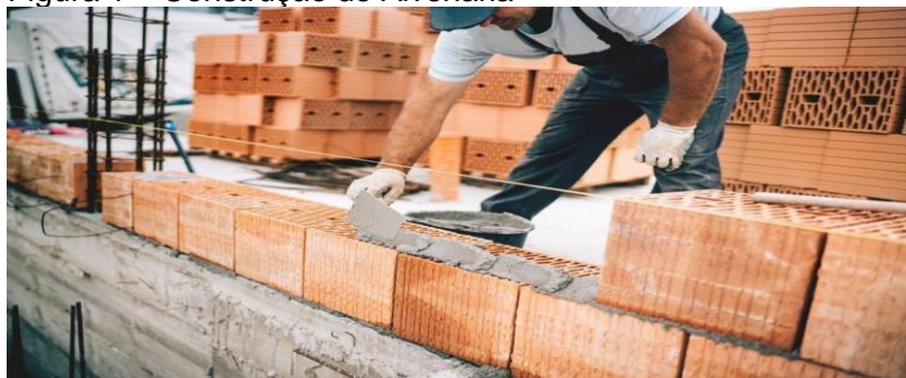
Figura 1 – Construção de Alvenaria
