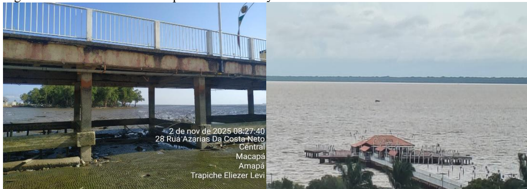
Figura 2 – Estrutura atual do trapiche Eliezer Levy
