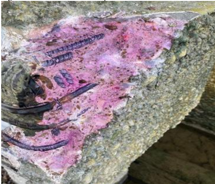
Figura 21- Ensaio de carbonatação
