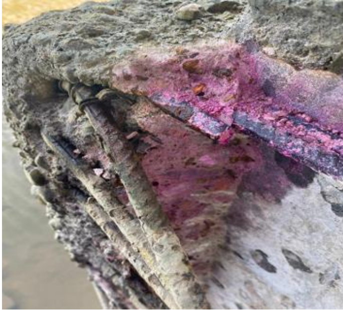
Figura 20- Ensaio de carbonatação
