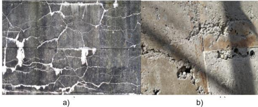
Figura 5- Lixiviação (a), Segregação (b)
