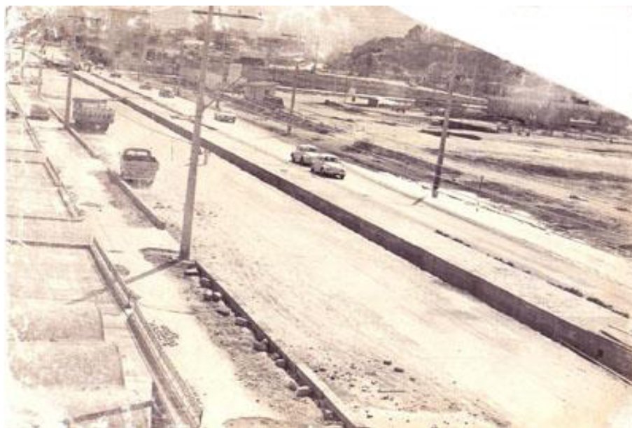
Figura 51: Vista da Avenida César Hilal em obras. Ao fundo a Avenida Leitão da Silva (década 1950)
