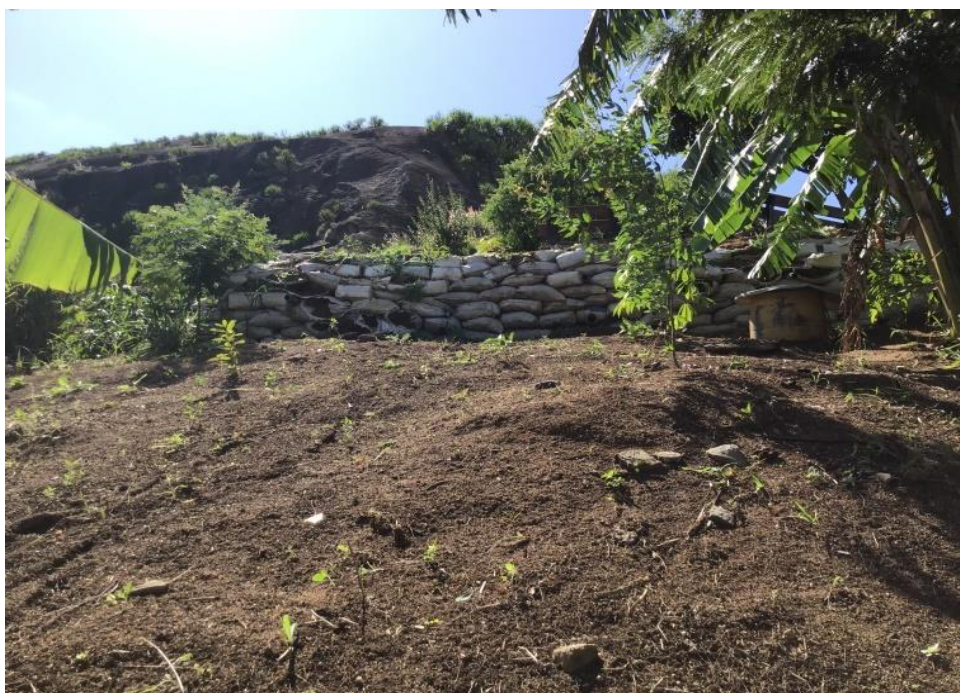
Figura 39: Muro das Lamentações, obras de melhorias para conter a erosão
