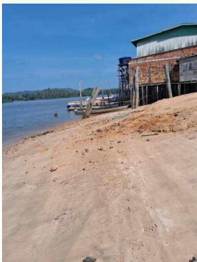
Figura 10 – Rampa de acesso
