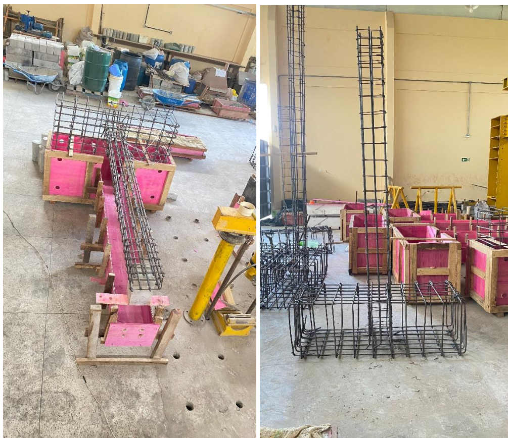
Figura 5.7 – Armaduras dos pilares e blocos (Fonte: Autor)
