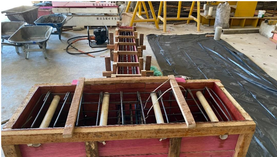
Figura 5.15 – Detalhe dos pilares na concretagem (Fonte: Autor)
