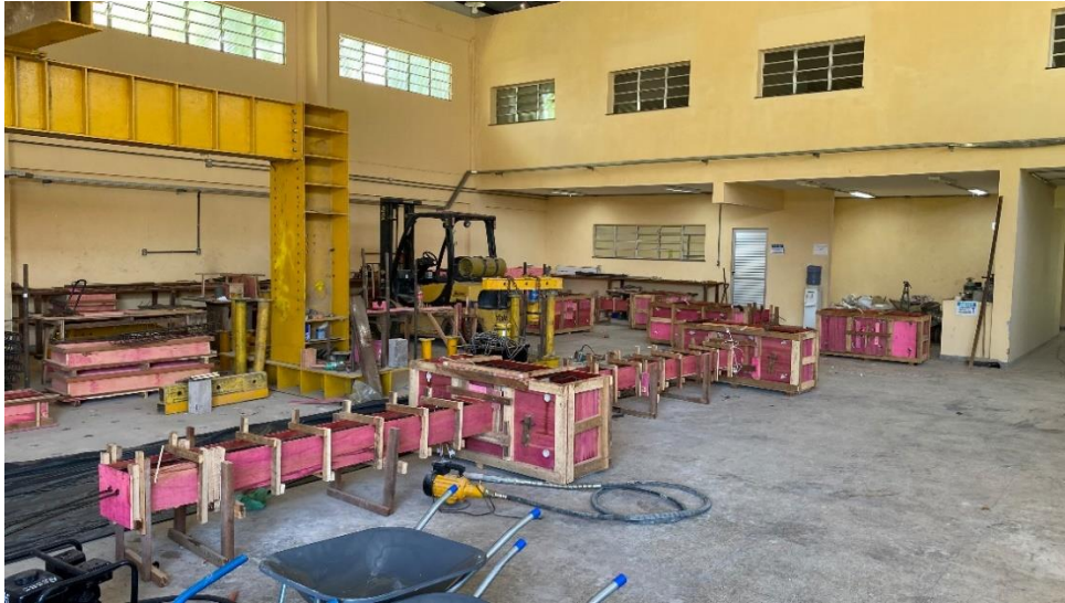
Figura 5.14 – Preparação dos pilares para concretagem (Fonte: Autor)
