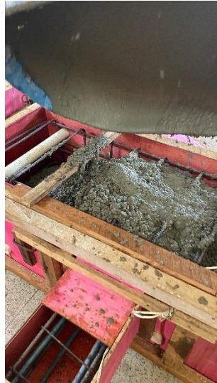
(b) Lançamento do concreto
