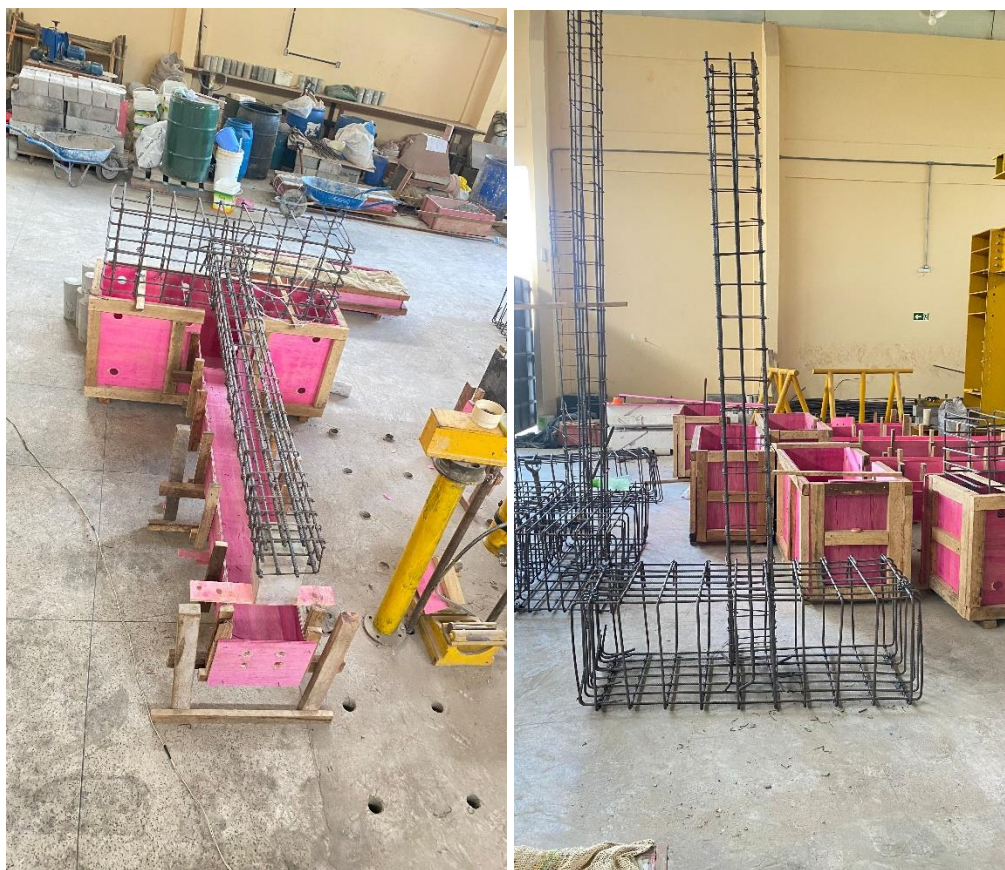
Figura 5.7 – Armaduras dos pilares e blocos (Fonte: Autor)
