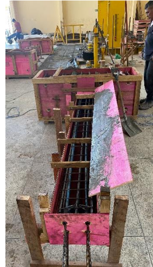
(c) Rampa para lançamento do concreto
