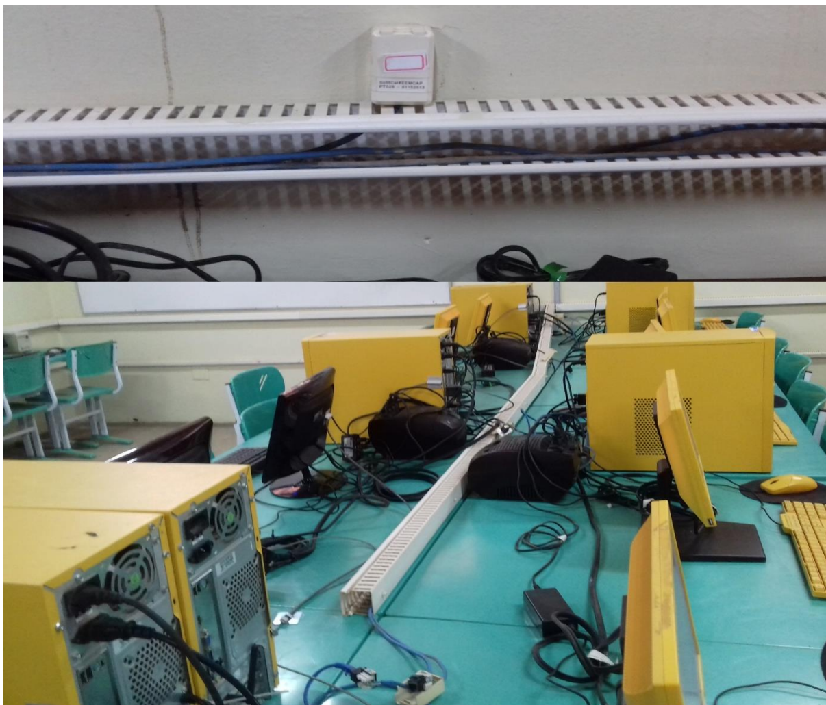
Figura 23 - Cabeamento Horizontal.
