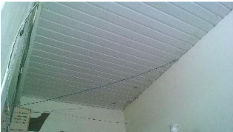
Figura 27 - Cabeamento Secundário utilizado na CAESA
