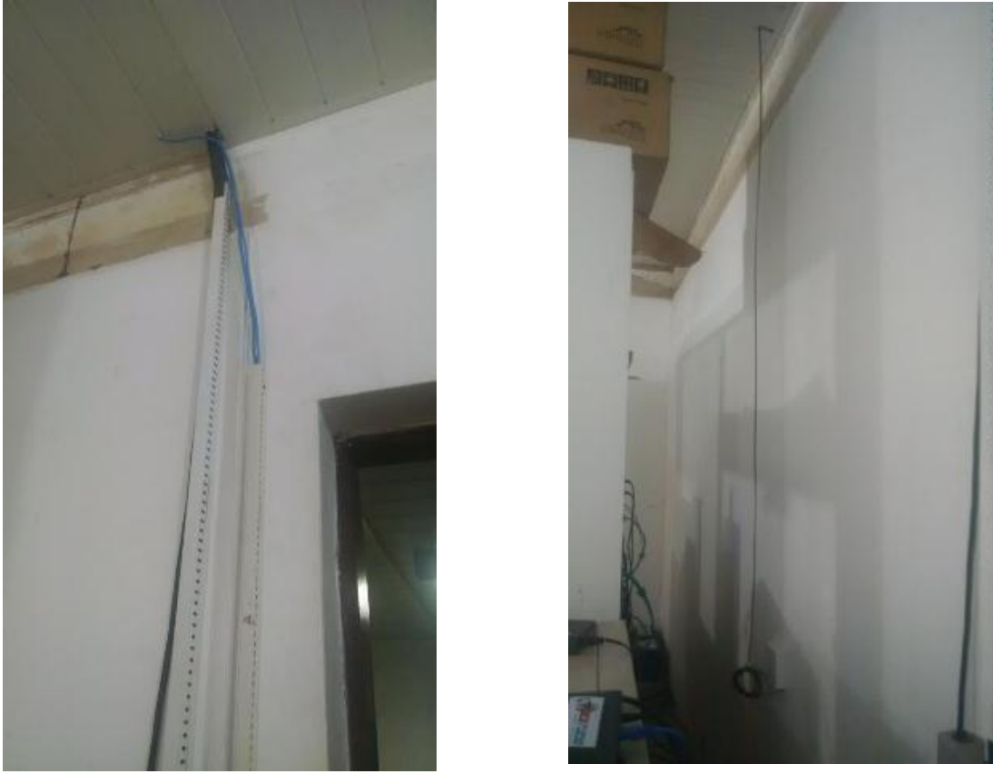
Figura 18 - Lançamento aéreo das fibras ópticas da TV Som e do PRODAP
