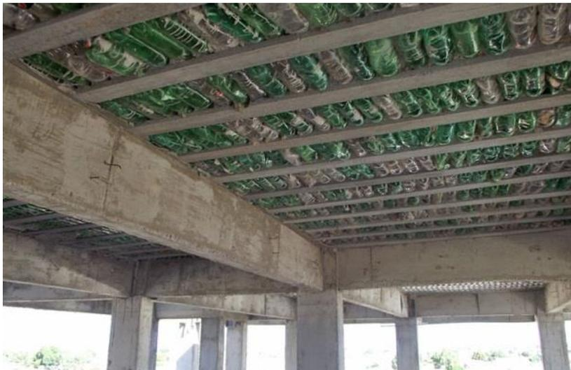
Figura 11 - Construção de lajes pré-moldadas utilizando garrafas PET (Gomes,2014)
