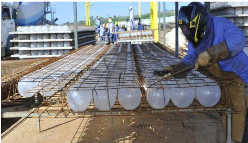
Figura 13 - Montagem da estrutura com BubbleDeck (Moreira,2014)
