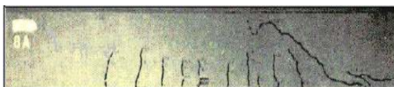
Figura 32 – Viga sem armadura de cisalhamento com ruptura no momento da primeira fissura inclinada (HANSON, 1958)
