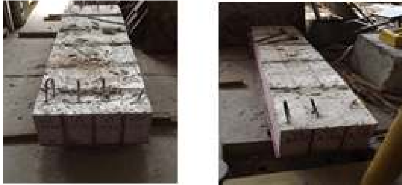
Figura 84 - Vigas desformadas
