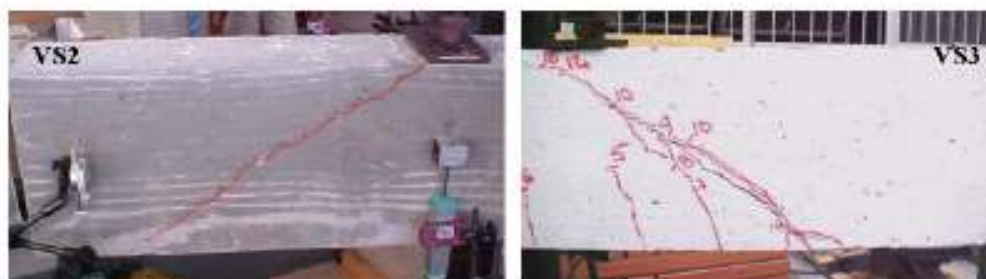
Figura 71 - Fissuração das vigas do grupo VS no momento da ruptura (CARELLI, 2002)
