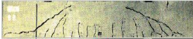
Figura 33 - Viga sem armadura de cisalhamento com ruptura após a ocorrência da primeira fissura inclinada (HANSON, 1958)
