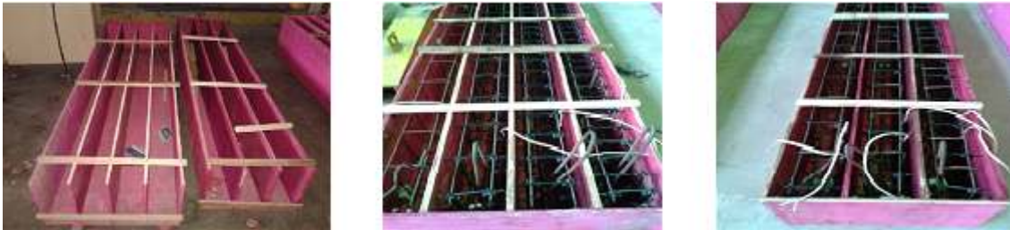
Figura 81 - Detalhes das fôrma e armaduras após suas montagens
